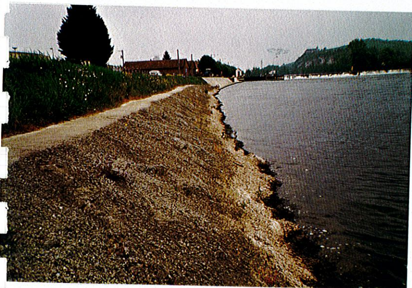
La rive droite de l'Yonne, en aval du barrage : cimentée, elle est totalement inhospitalière pour la faune et la flore.
