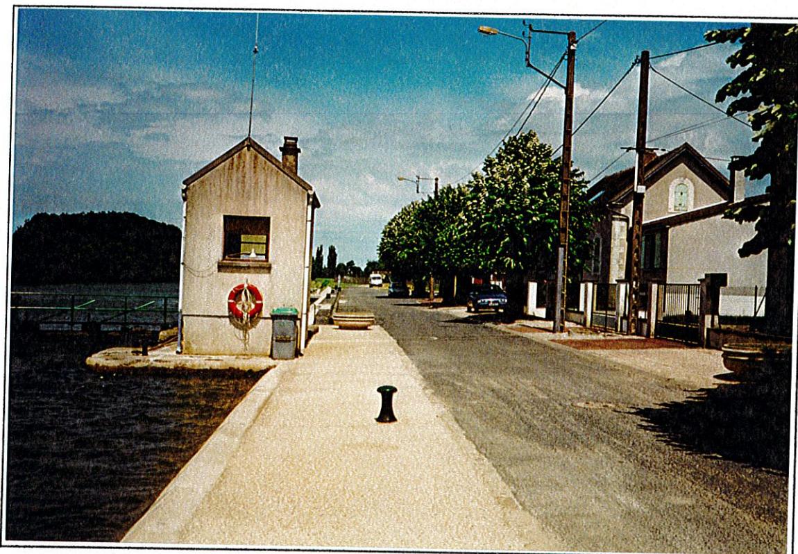
Abords de la retenue de Saint-Martin, écluse et maison éclusière
