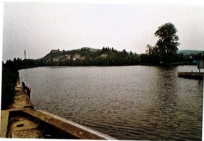
Vue générale de l'Yonne en amont du barrage-écluse de Saint-Martin-du-Tertre.
